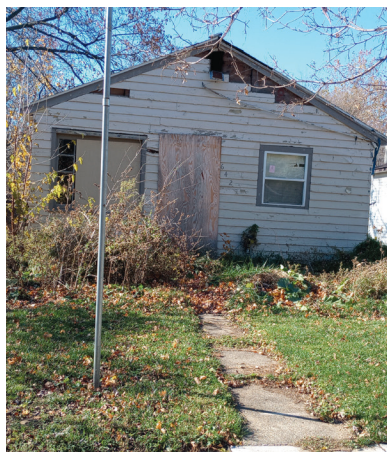
642 S. Francis Ave., Lansing
